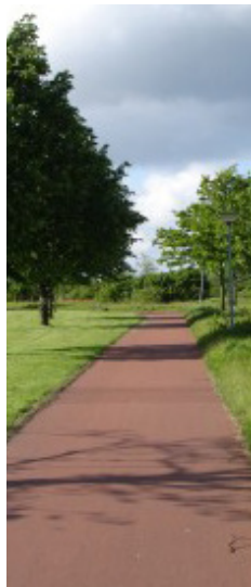
fietspad rood asfalt
